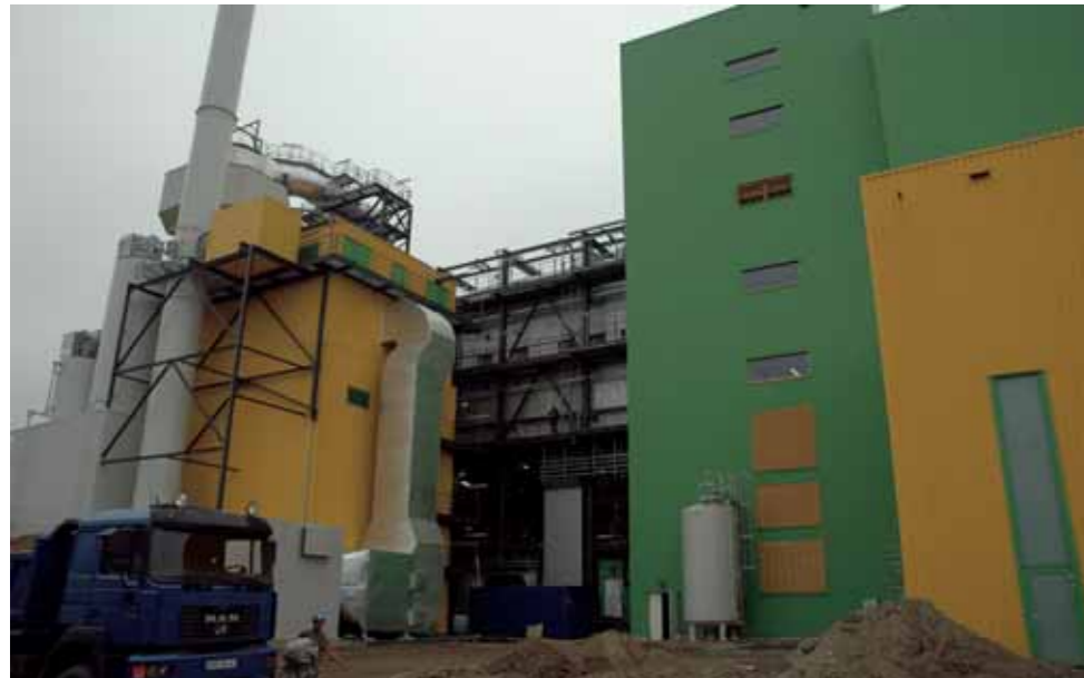
Neues EBS-Kraftwerk in Stavenhagen
